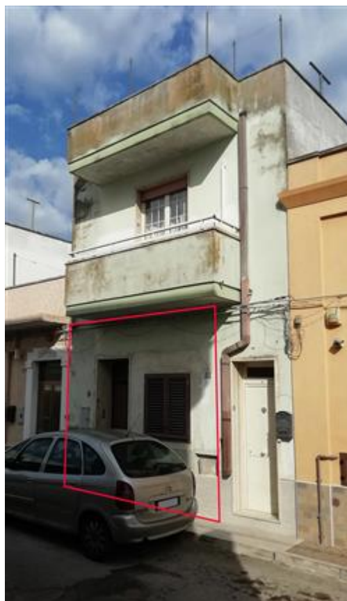
2 - VISTA DELL'EDIFICIO DA VIA GIANTURCO
