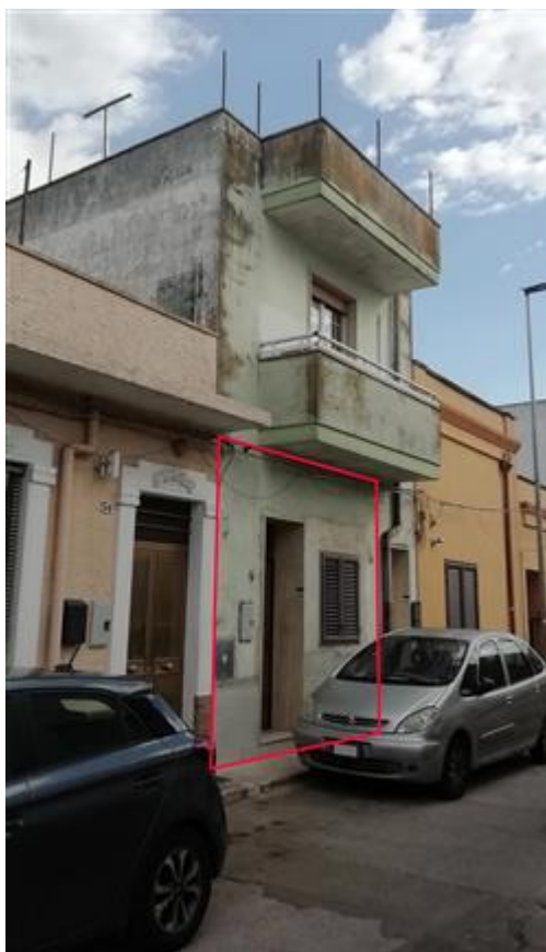
1 - VISTA DELL'EDIFICIO DA VIA GIANTURCO
